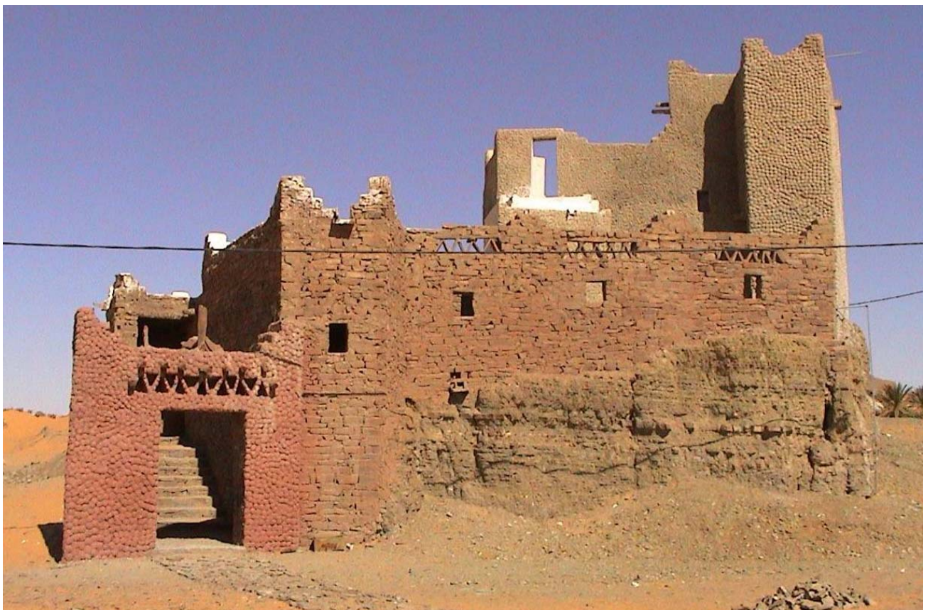
Un super Ksar en cours de réhabilitation dans la vallée de Timimoune en 2005: Pierre et terre sont harmonieusement associées.
