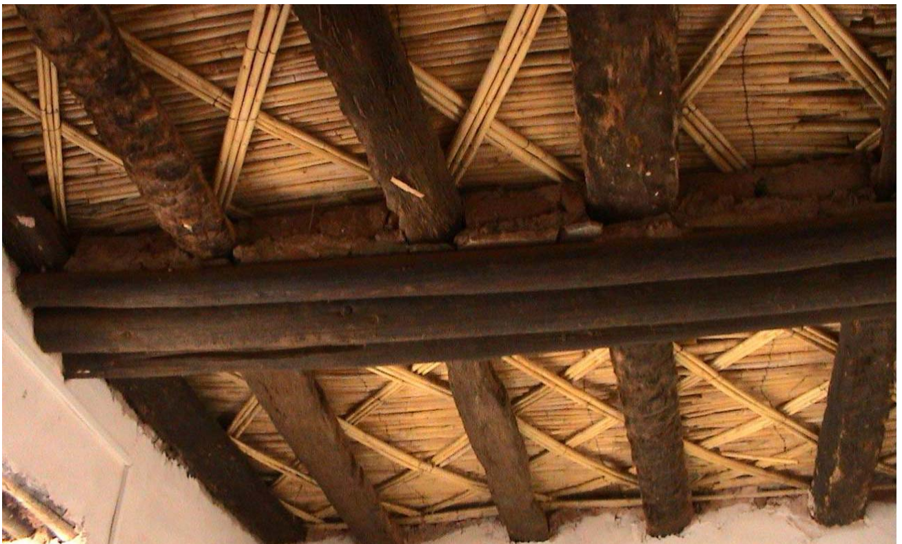
Plafond en cours de réhabilitation en 2005 à Kenadsa – Sud de Bechar
